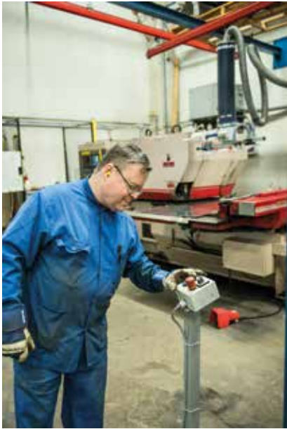
Valoverhon rajaaman alueen ulkopuolella on tölppä, johon on sijoitettu koneen hätäseis-painike, toimintatavan valintakytkin, käynnistyspainike sekä tahtiajon kuittaus-painike.
